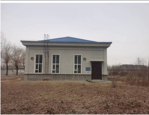
串湖污水厂危废间（1）
