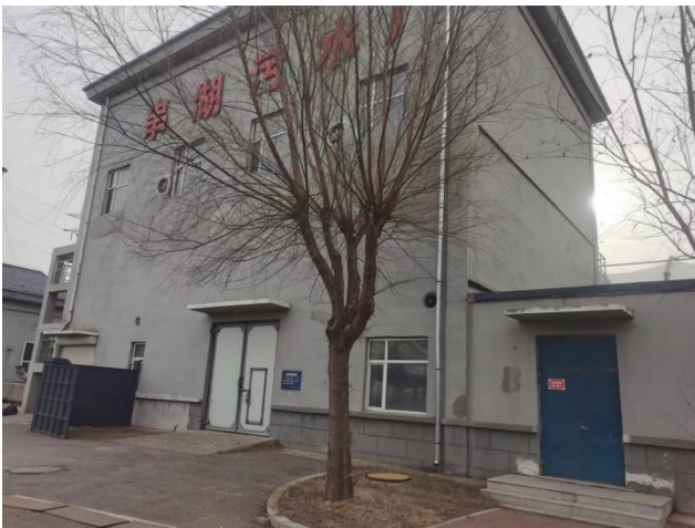
串湖污水厂细格栅间、高效沉淀池
