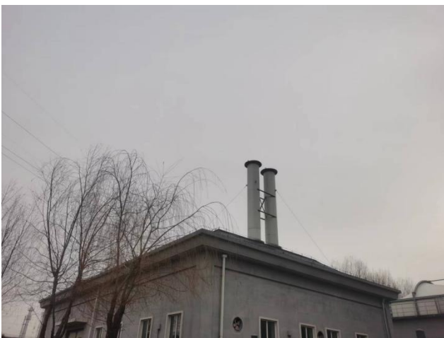
串湖污水厂1号除臭车间排气筒
