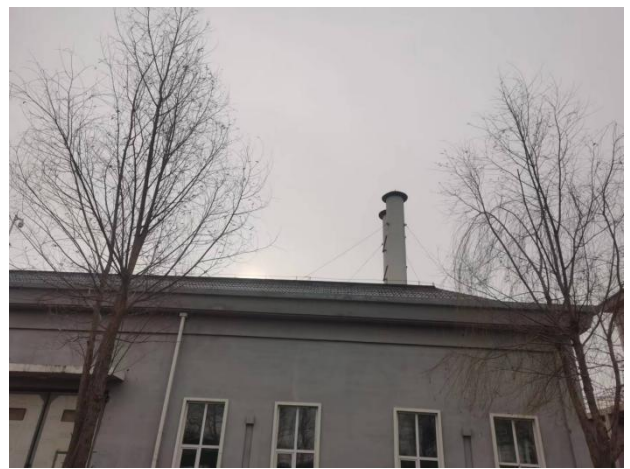
串湖污水厂2号除臭车间排气筒
