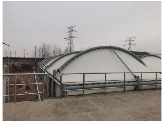
串湖污水厂生化池
