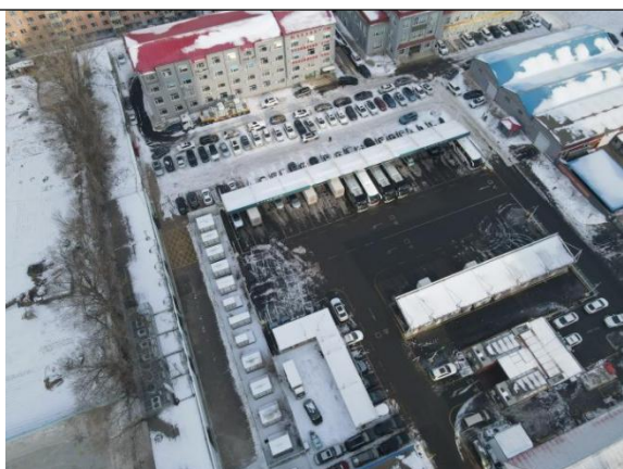
吉林省送变电工程有限公司及国家电网充电桩 （北）
