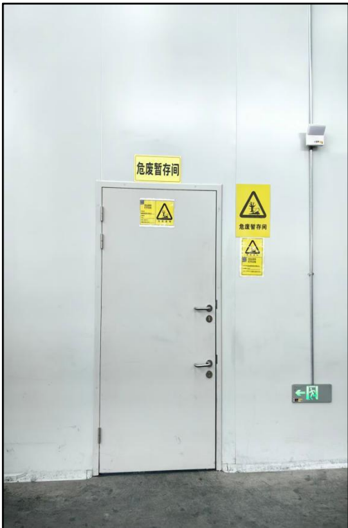
危险废物贮存库（外部）
