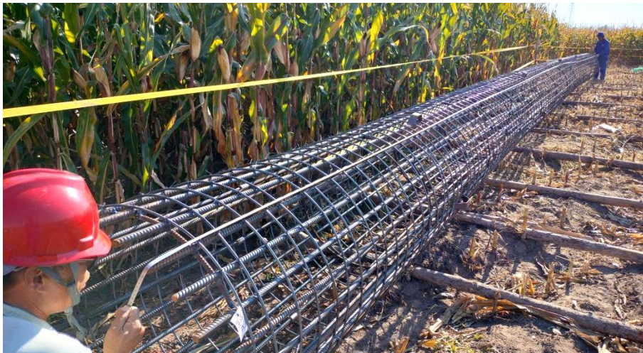
严控边界措施示例照片
