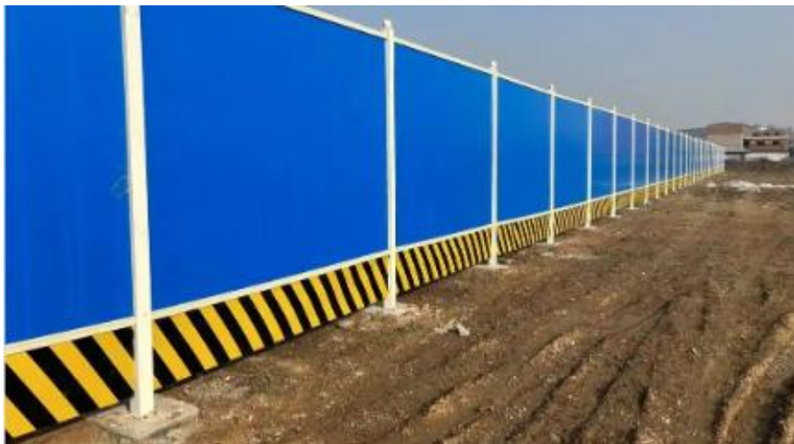
施工围挡措施示例照片
