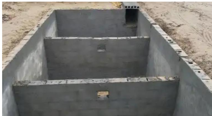
施工沉淀池措施示例照片
