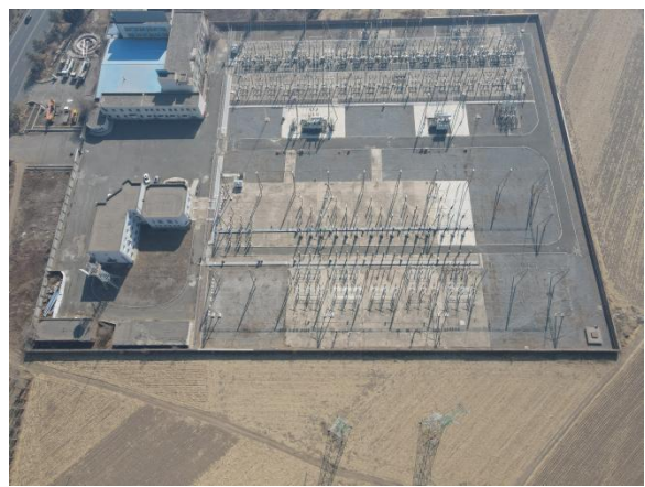
双阳 220kV 变电站西北侧
