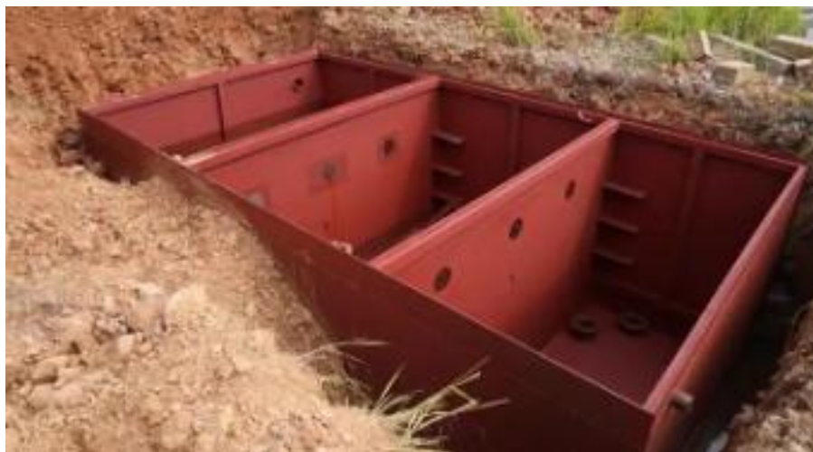
施工沉淀池措施示例照片
