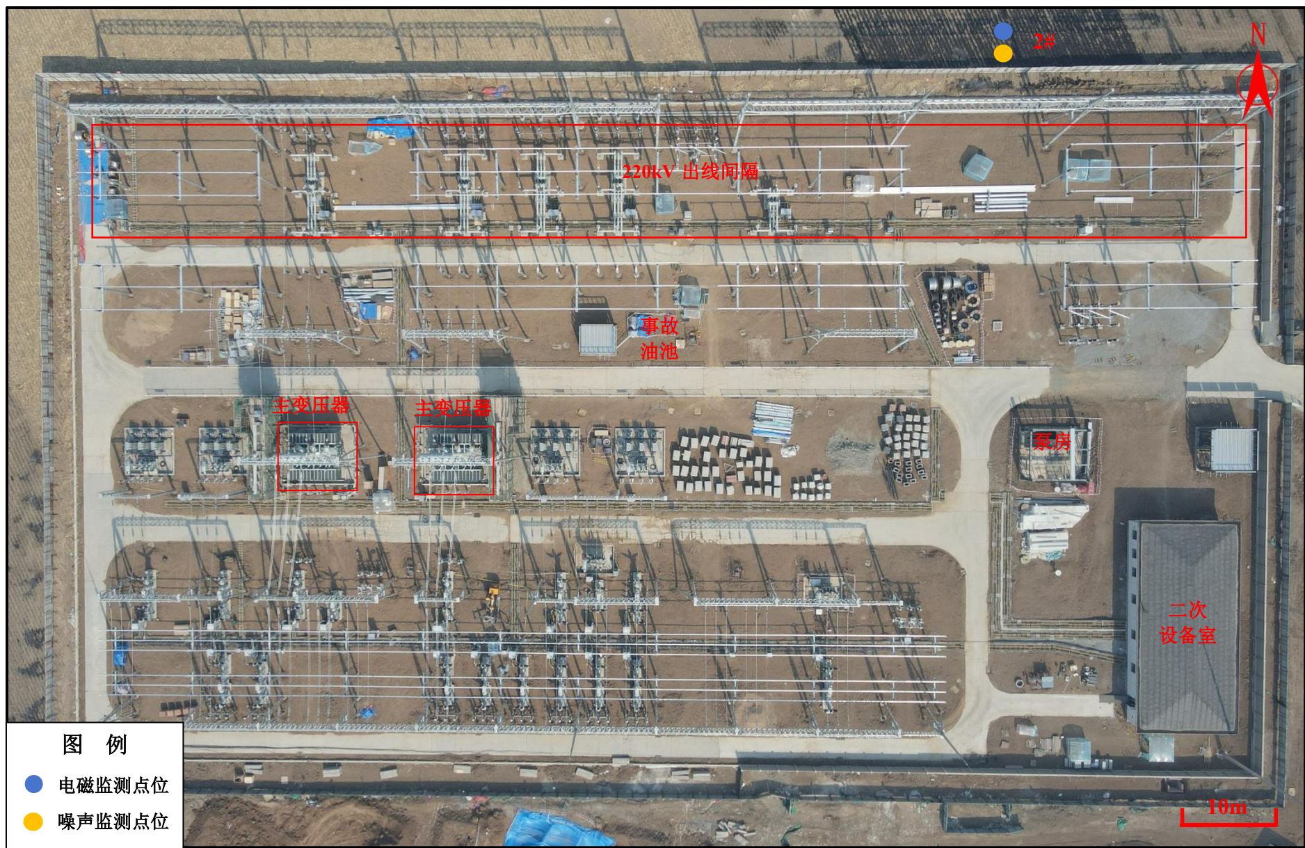
附图3 锦绣 220kV 变电站现状 (2026.3.16)
