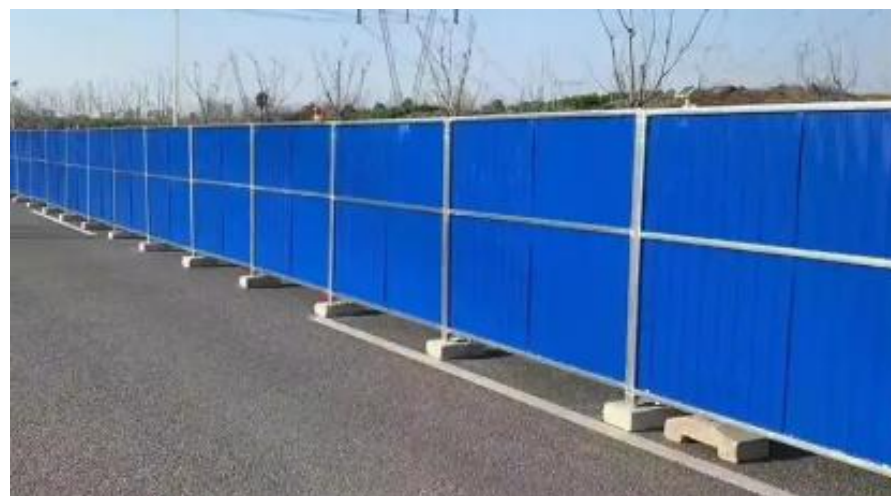
施工围挡措施示例照片
