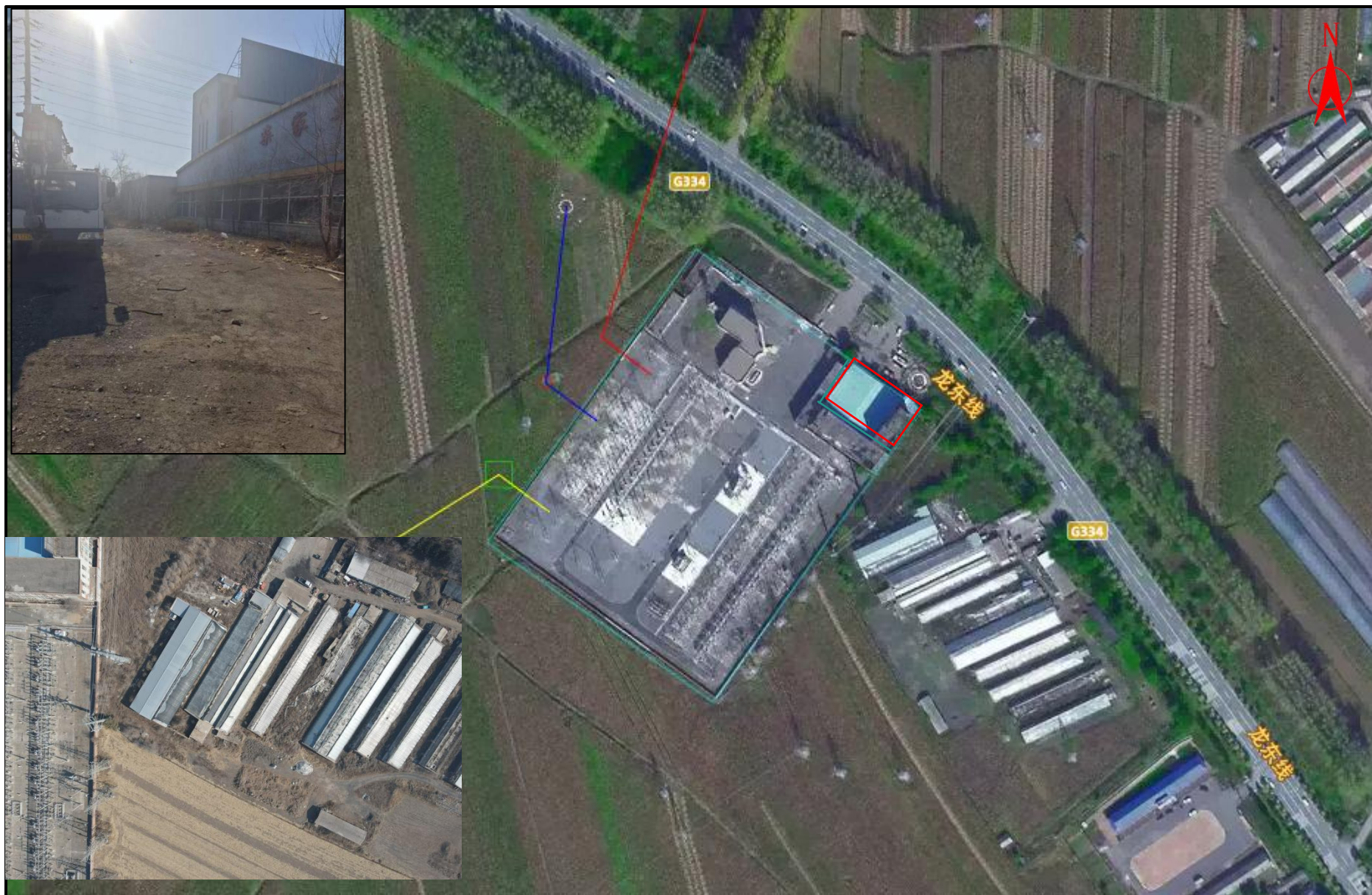
附图 5 双阳变电站东侧 1m 废弃厂房、16m 厂房
