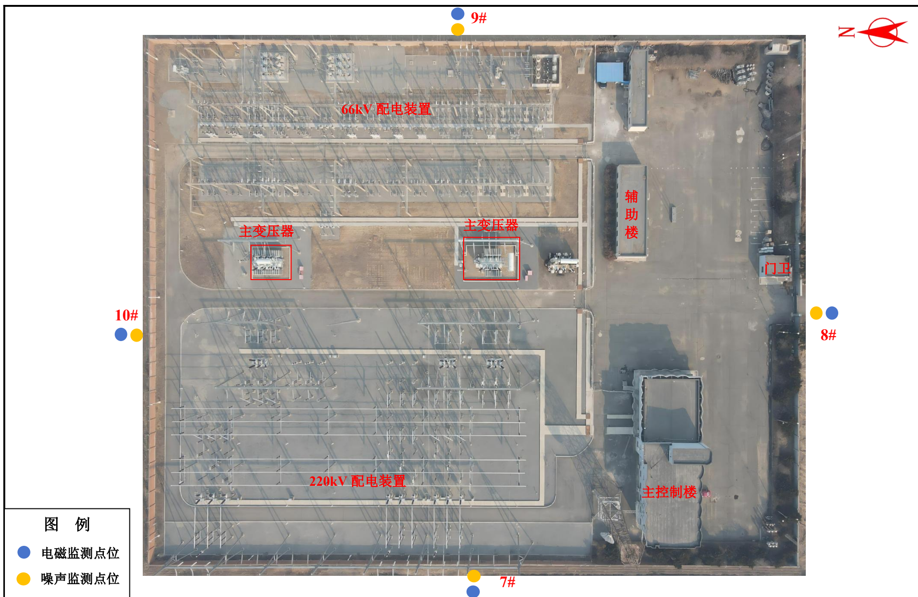
附图 4 伊通 220kV 变电站现状 (2026.3.16)
