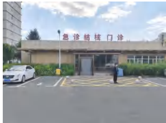
(6) 综合楼北侧急诊结核门诊
